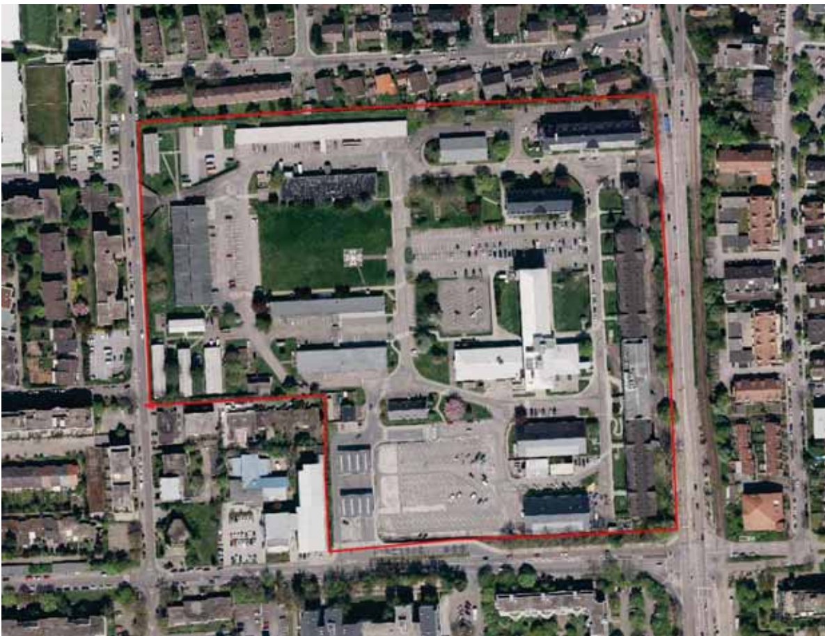
Abbildung 23: Die Konversionsfläche US Hospital im Luftbild (Bild: Stadt Heidelberg)
