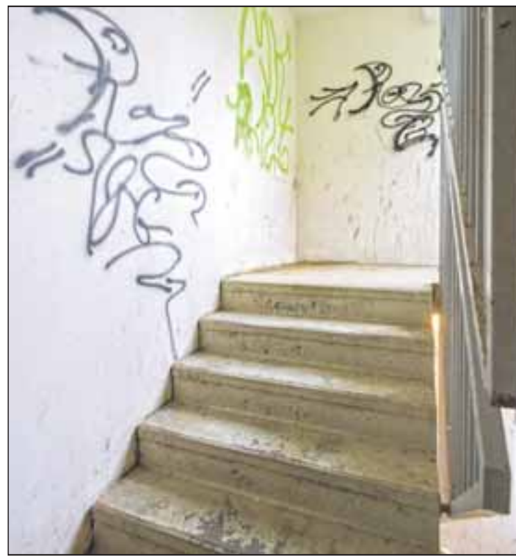
Das Treppenhaus ist völlig verdreckt – und nur wenige der Lampen funktionieren. Die Geländer sind verrostet und schmutzig. Fotos: Rothe
