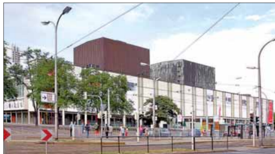
Wurde zwischen 1988 und 1994 für 72 Millionen Mark saniert: das Nationaltheater Mannheim. Wichtigste Baumaßnahme war ein zweiter Bühnenturm. Foto: Alfred Gerold
