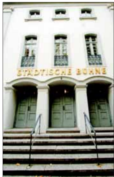
Ab Sommer 2009 wird das Städtische Theater saniert. Dann sollen auch die Haupttüren wieder geöffnet werden. Foto: Joe
