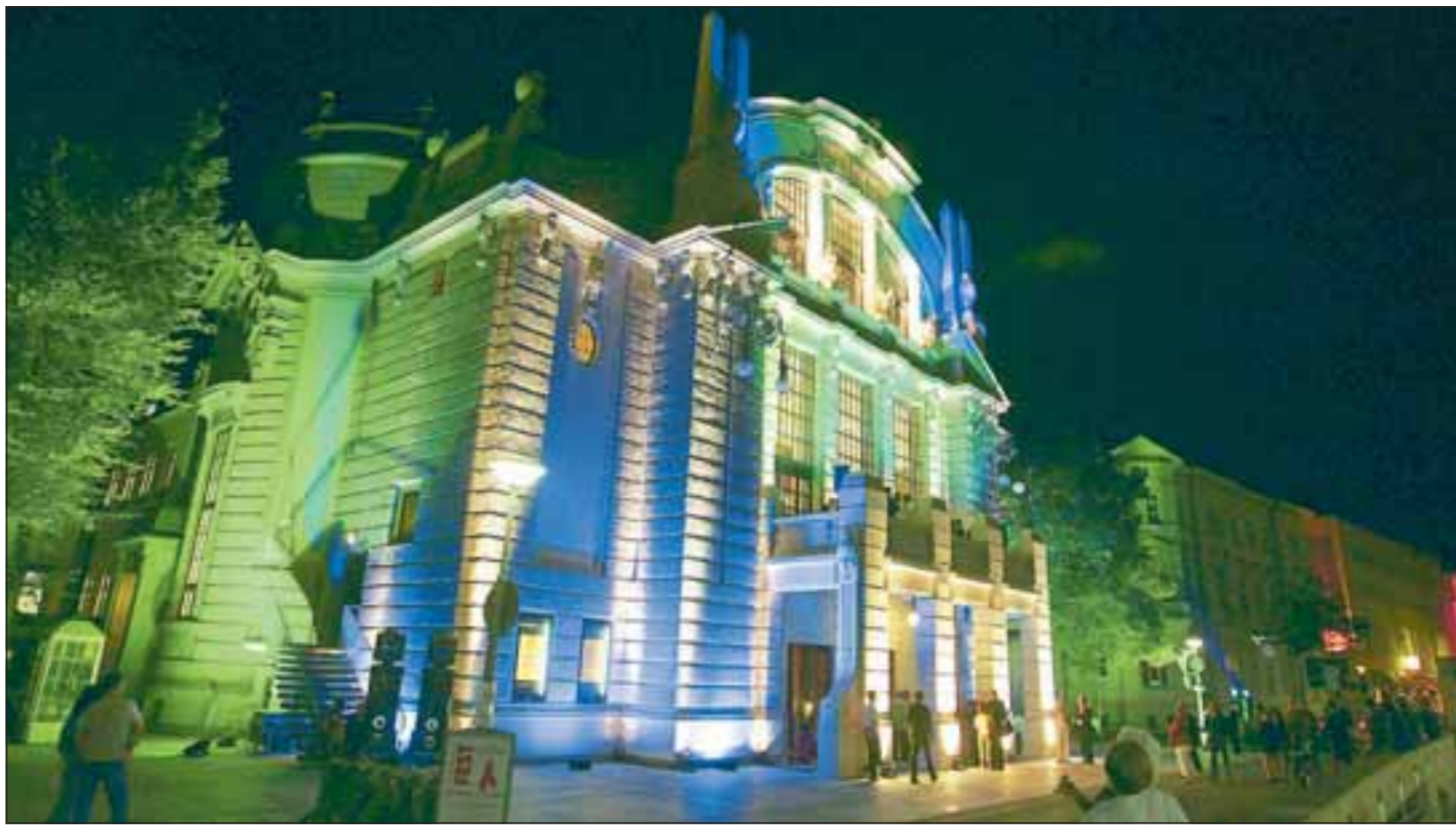
Bielefeld hat in zentraler Lage, am Niederwall, ein imposantes Stadttheater, das 1904 eingeweiht wurde. 2004 bis 2006 wurde es innen und außen komplett saniert – und ist der Stolz der Stadt in Ostwestfalen. Fotos (3): Theaterstiftung Bielefeld
