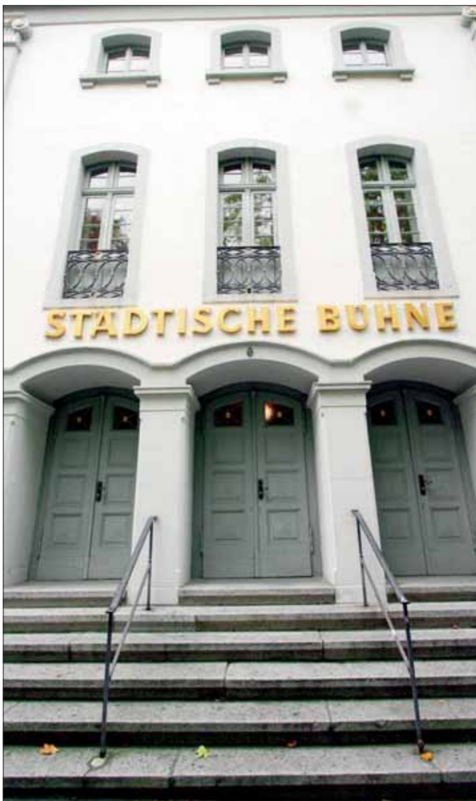
Verschlossene Türen bei der Städtischen Bühne: Das Herzstück des Theaters darf bis auf Weiteres nicht mehr genutzt werden. Foto: Joe
